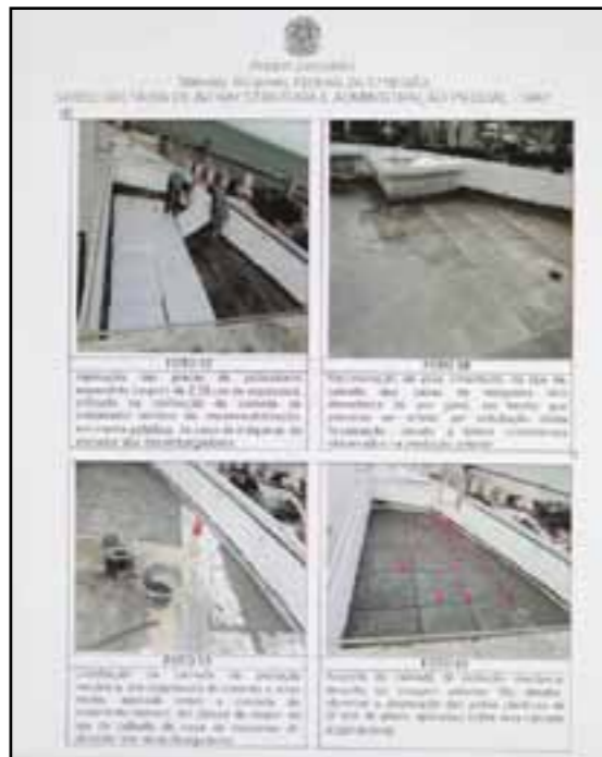
Relatório inclui imagens de obras
